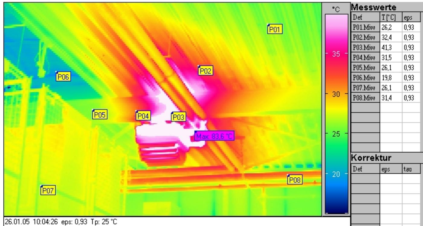
Obwohl das Thermostat das Deckenheizgerät abgeschaltet hatte, wurde das Register mit Heißwasser durchströmt.
